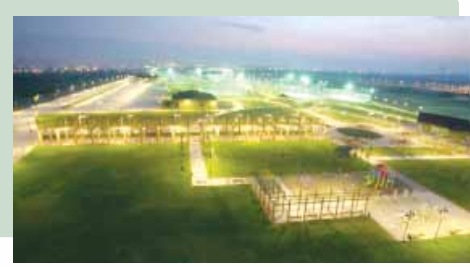
Rehabilite Edilen Mersin Depolama Alanı
