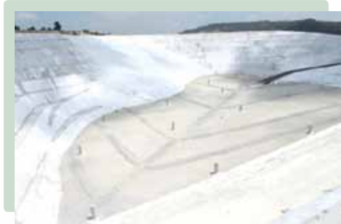
Katı Atık Düzenli Depolama Alanı 3. Lotu
