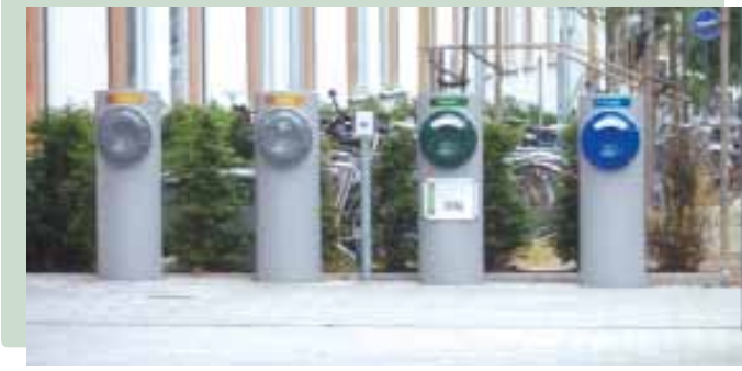
İsveç'te bir vakumlu atık toplama sistemi
