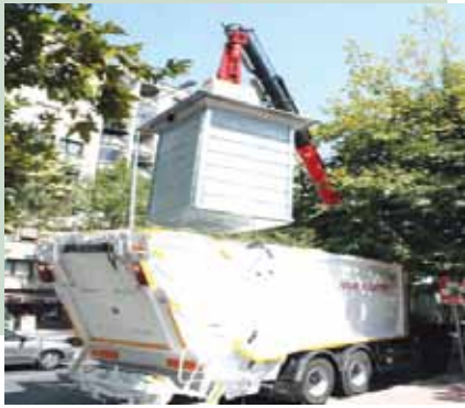
İlkadım Belediyesi yer altı konteyner sistemi
