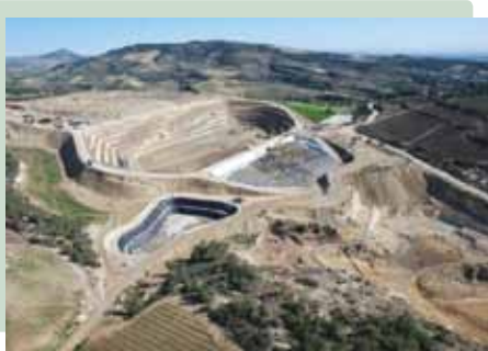
Mersin Büyükşehir Belediyesi Düzenli Depolama Alanı
