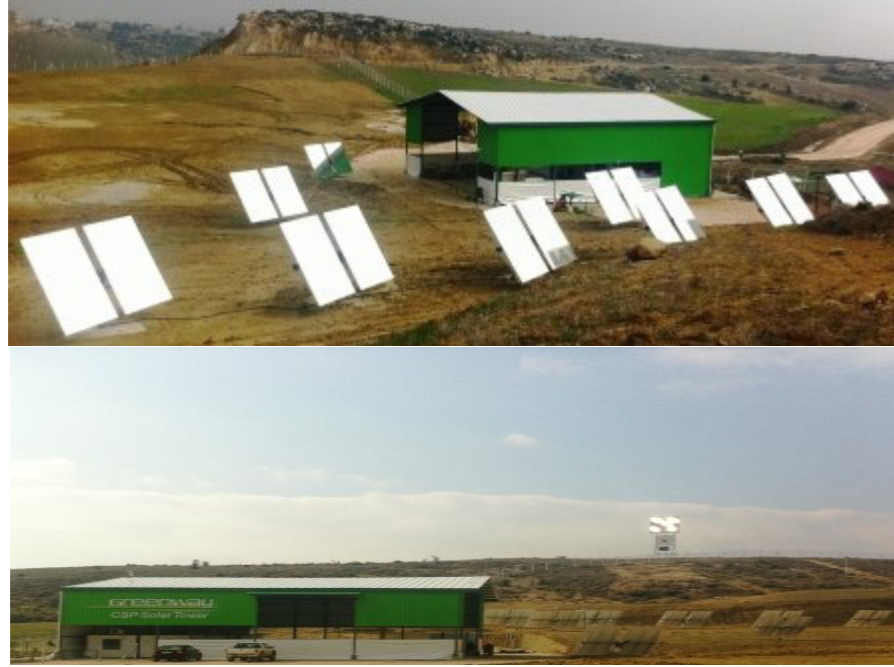
Şekil 27: Mersin Greenway Güneş Santrali Projesi
