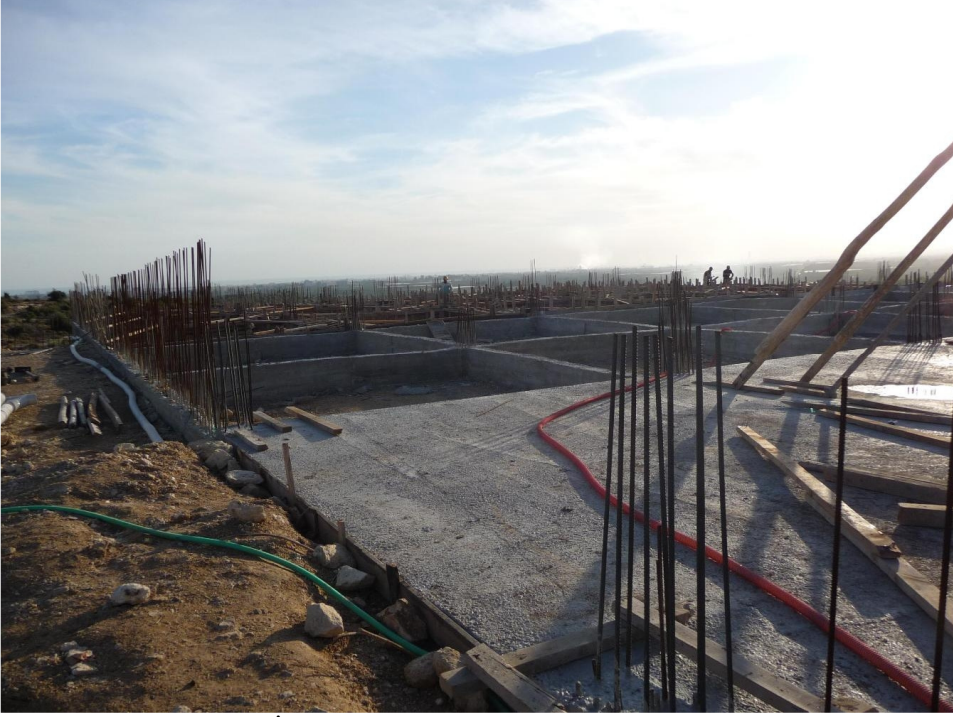
TR62-08-01/019 EKO-SİS Soğuk Hava Deposu Tesisi Projesi
