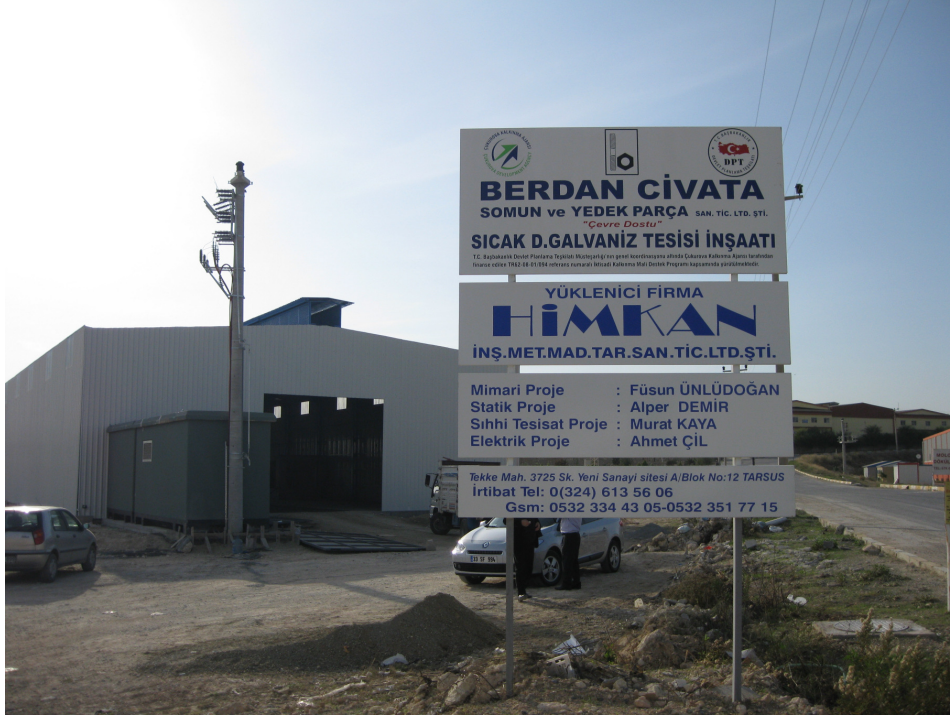
TR62-08-01/094 Çevre Dostu Daldırma Galvaniz Tesisi
