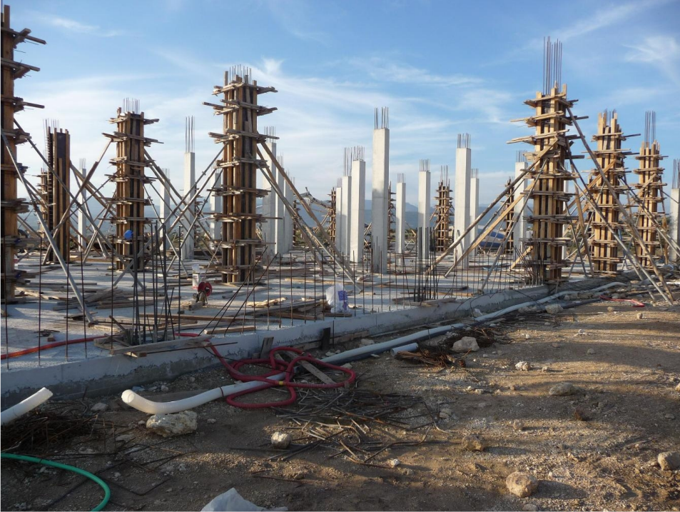
TR62-08-01/019 EKO-SİS Soğuk Hava Deposu Tesisi Projesi
