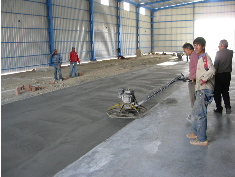
TR62-08-01/094 Çevre Dostu Daldırma Galvaniz Tesisi
