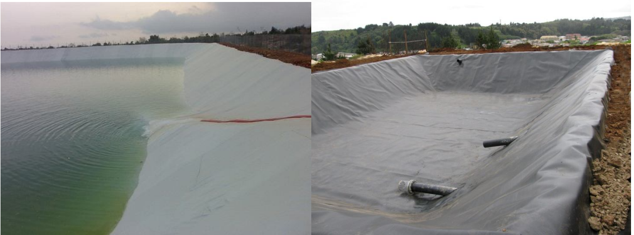
Şekil 2. Geomembran örtü ile hazırlanan havuz ve göletler
