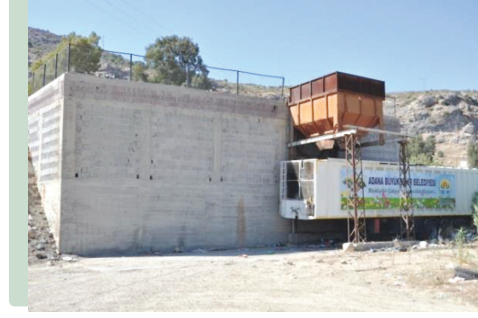
Karaisalı Belediyesi Aktarma İstasyonu
