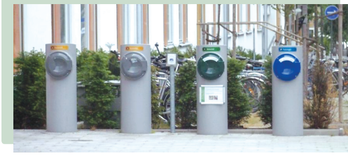
İsveç'te bir vakumlu atık toplama sistemi
