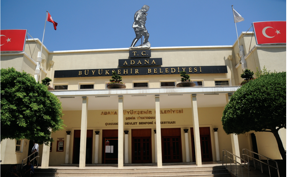
Adana Büyükşehir Belediyesi Tiyatrosu ve 75.yıl Sanat Galerisi'nin bulunduğu Eski Belediye binası
